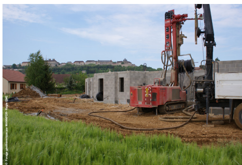
© Forage géothermique par MANNFOR - Régis EME
