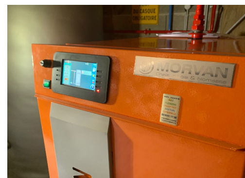
© Chaudière biomasse bois bûche par JEANNIN S.A.R.L.
