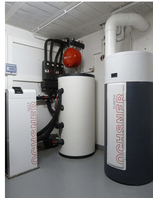
© Pompe à chaleur et ballon thermodynamique par Guy CONSTANTIN
