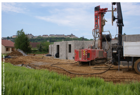
© Forage géothermique par MANNFOR - Régis EME
