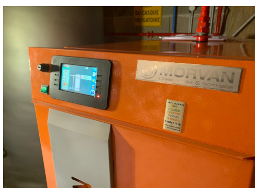
© Chaudière biomasse bois bûche par JEANNIN S.A.R.L.
