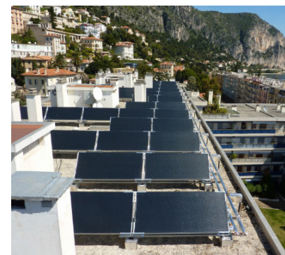
© Solaire collectif à stockage ECS par ASI - Gérard CALVET
